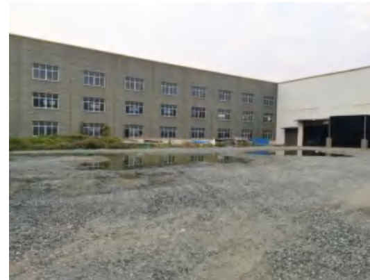
项目反应车间场地现状
