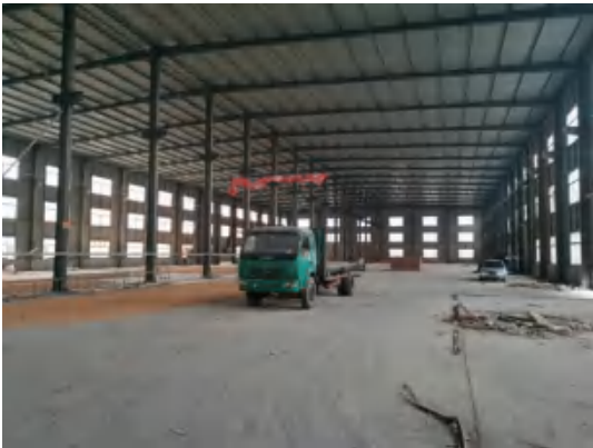
项目干燥车间场地现状
