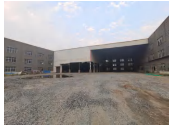
项目反应车间场地现状
