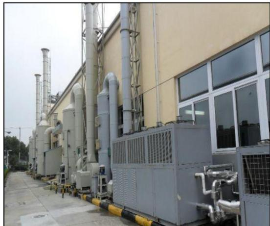
图 7-8 某电镀企业酸雾吸收塔实景图
