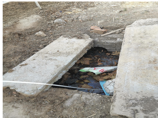
牛舍旁污水管道
