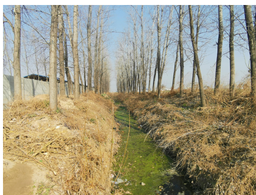
项目东侧排涝沟
