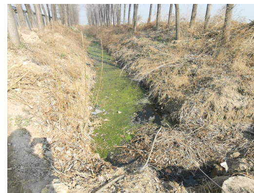
粪污随雨水排入东侧二支渠
