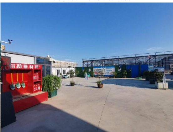
迁建厂区建设现状 2
