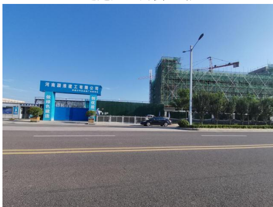
迁建厂区建设现状 1
