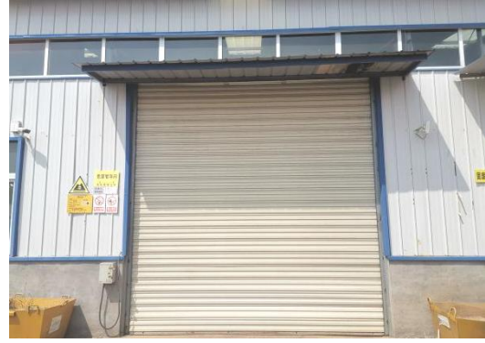
危险废物贮存仓库外部现状
