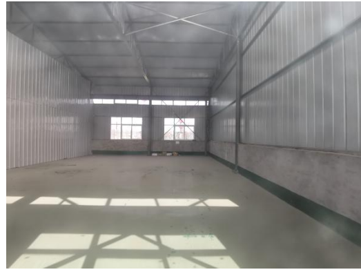
一般固废暂存间内部现状
