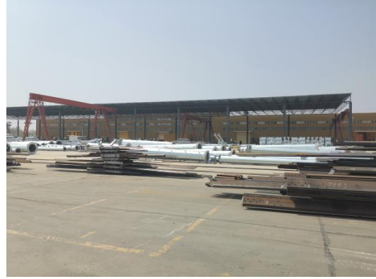
已建热镀锌车间及行吊场地
