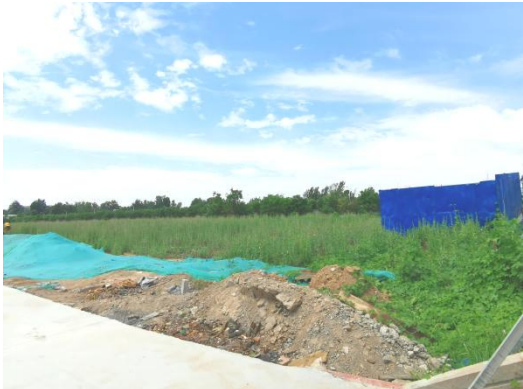
本次工程管件加工车间占地现状
