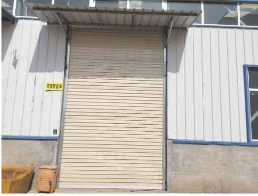
一般固废暂存间外部现状
