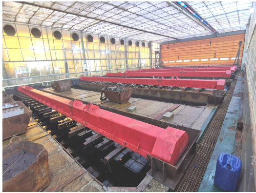
已建酸洗房顶侧吸风
