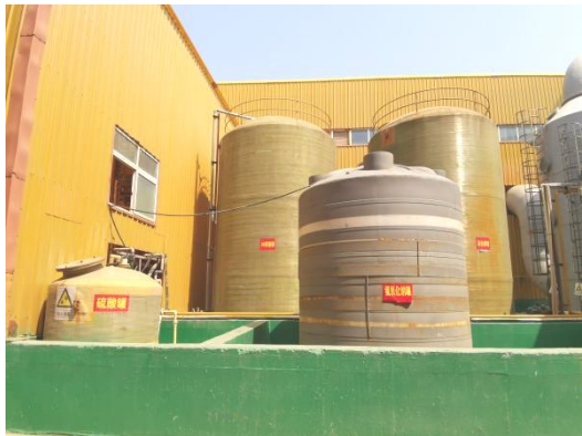
污水处理站处储罐区
