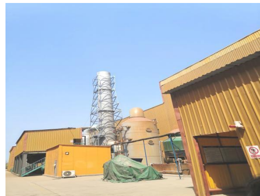
已建酸雾洗涤塔排气筒
