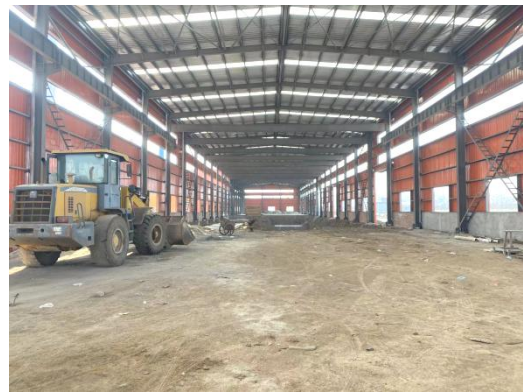
拟建 2#镀锌车间内部现状
